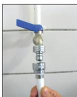
2. Klicka fast slangen med 1/2" snabbkoppling på vattenkranen
