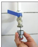
1. Vissez le raccord 1/2" (article n° 0700) sur le robinet d'eau.
