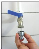
1. Montera 1/2" hannippel på vattenkranen.
